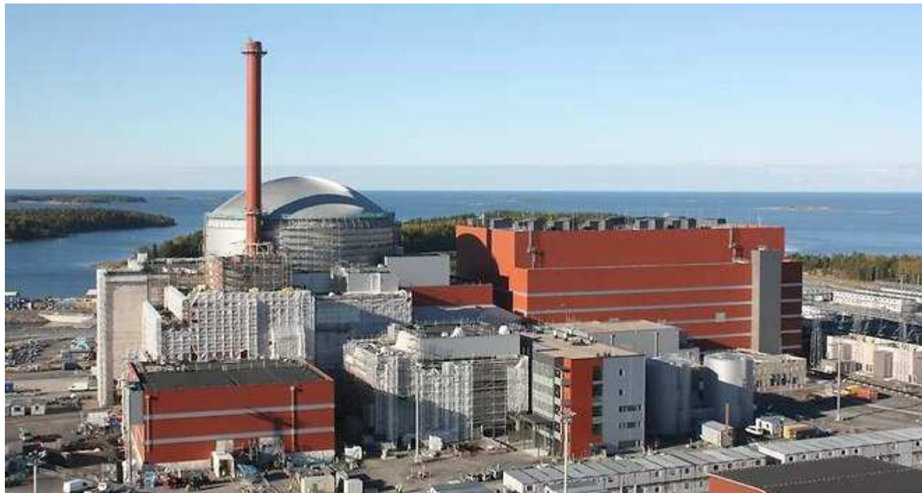
Le chantier du réacteur EPR d' Ouliluoto (Finlande). - Areva
