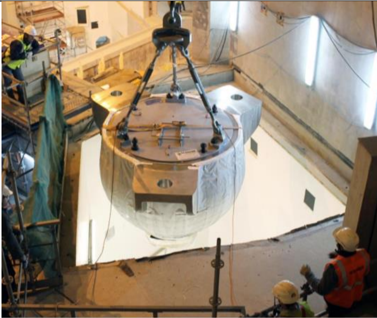
Mars 2014-Introduction de la volute de la pompe primaire dans sa casemate
