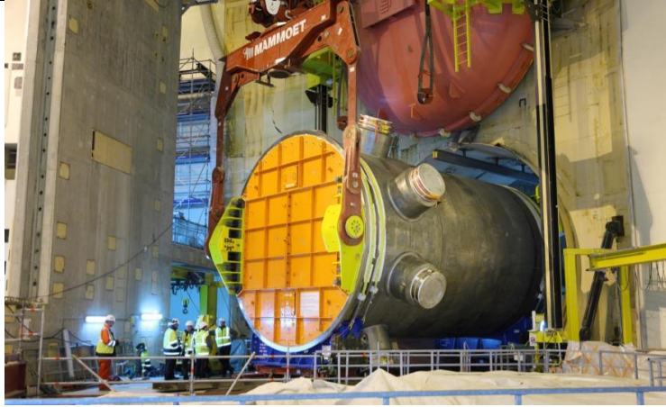
Janvier 2014- Introduction de la cuve dans le bâtiment réacteur
