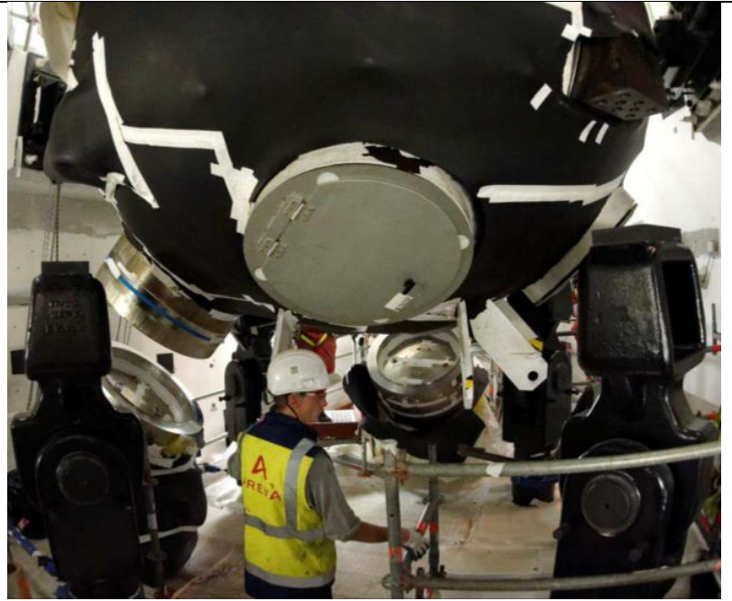
Septembre 2014 - Accostage du GV sur les béquilles supports
