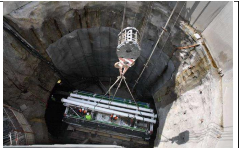
Mai 2009-Descente des éléments du tunnelier par le puits à terre
