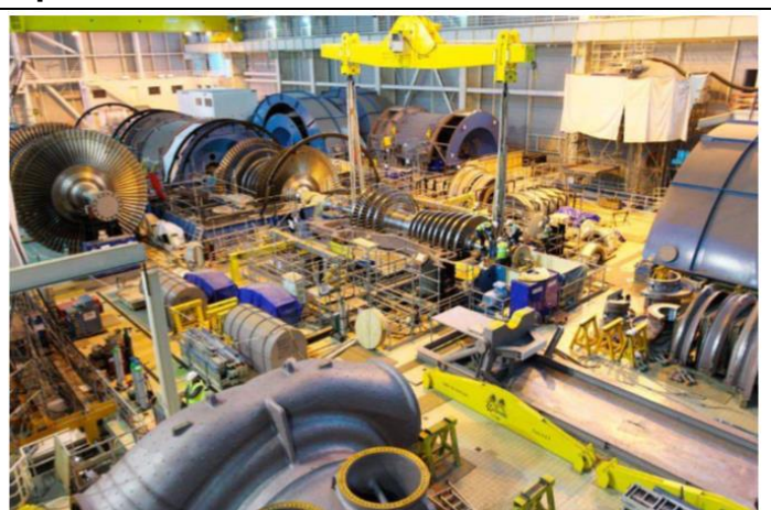
Salle des machines- Mise en place des rotors haute-moyenne et basse pression de la turbine Novembre 2011.
