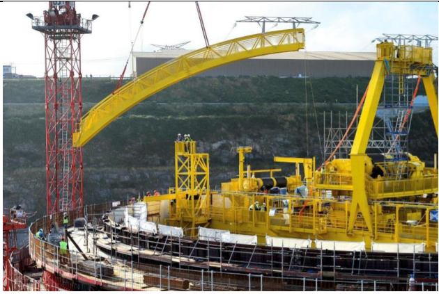
Juillet 2013-Mise en place de l'escalier
