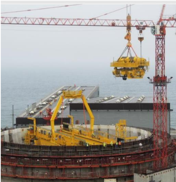
Juillet 2013- Mise en place de l'arceau et du chariot de manutention du pont polaire
