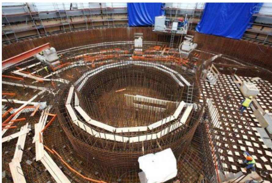
Ferrailage du bâtiment réacteur et du puits de cuve- A droite mise en place des platines supports du liner du récupérateur de corium.
