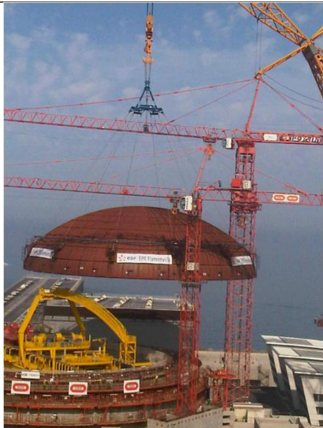
Juillet 2013 - Mise en place du dôme métallique
