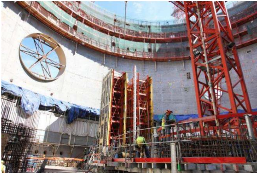
Août 2010 Installation des coffrages de piscine dans le bâtiment réacteur
