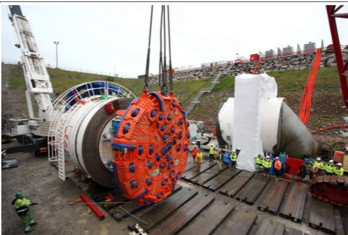
Mai 2009-Assemblage de la tête du tunnelier
