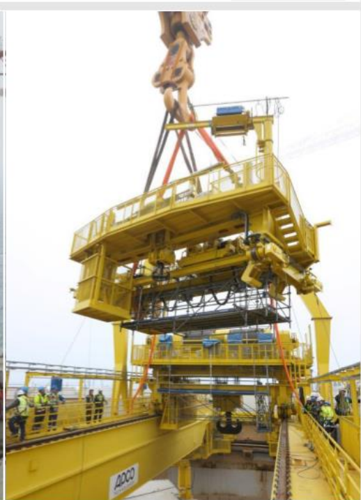
Juillet 2013- Mise en place de l'arceau et du chariot de manutention du pont polaire
