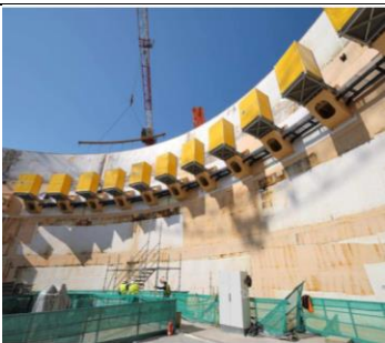
Avril 2013 - Les plots supports du rail du pont polaire sont en place avant d'être scellés entre l'avant dernière levée de béton et la dernière levée de béton de l'enceinte interne.
