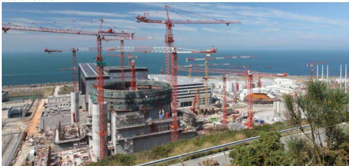
Août 2010- vue générale est-ouest
