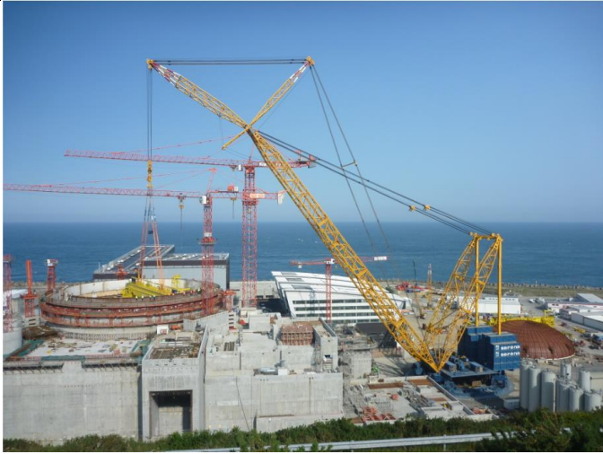
25 juin 2013. La première poutre du pont polaire est encours de pose.
