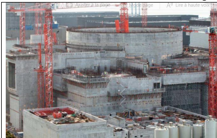
Novembre 2011- vue de la partie nucléaire.
