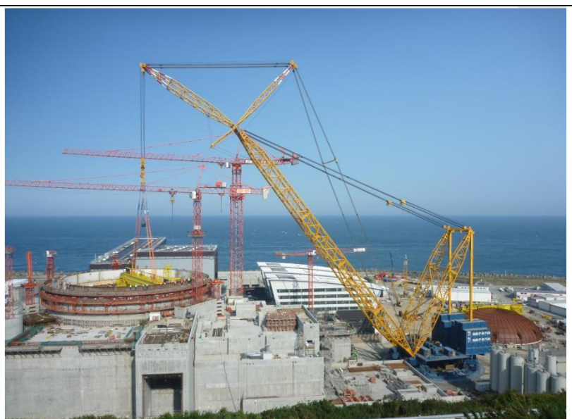
25 juin 2013. La poutre du pont polaire est encours de pose.
