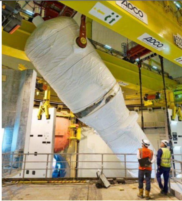
Septembre 2014 - Mise en place d'un GV dans sa casemate
