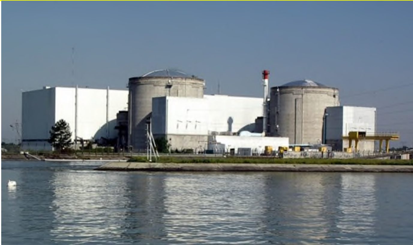
Centrale de Fessenheim source Wikipedia
